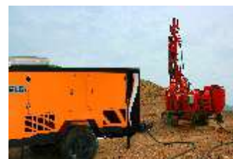
Compressores para Perfuração e Movimentação da Perfuratriz
