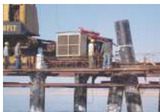
Mineração no Mar Morto
